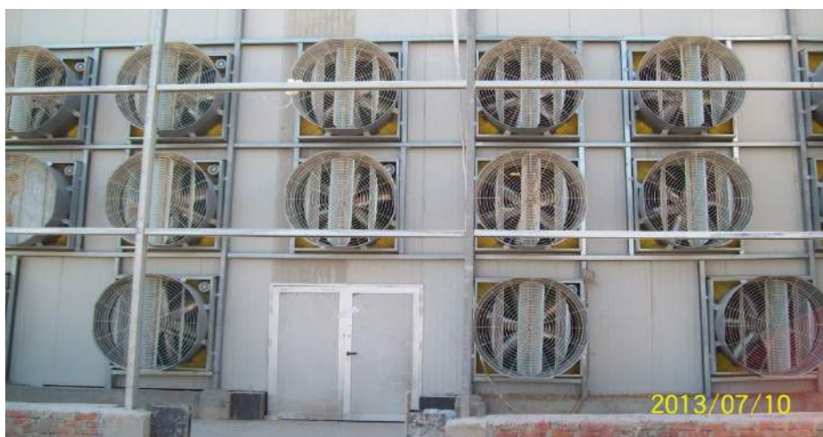
Рисунок 3. Тунельна вентиляція в пташнику
